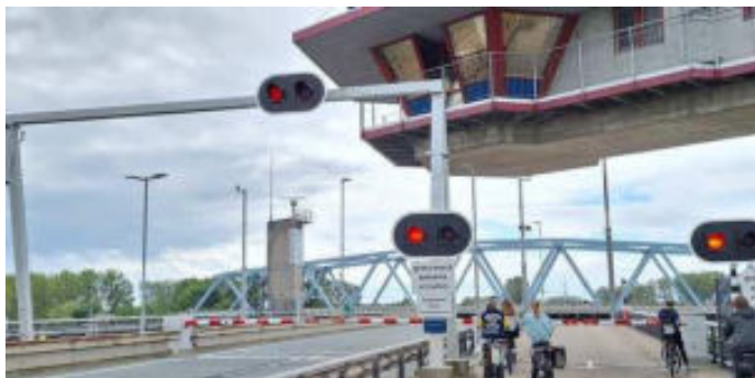
Ook de bij iedereen bekende en beruchte brug bij Sluiskil lag op onze route.
