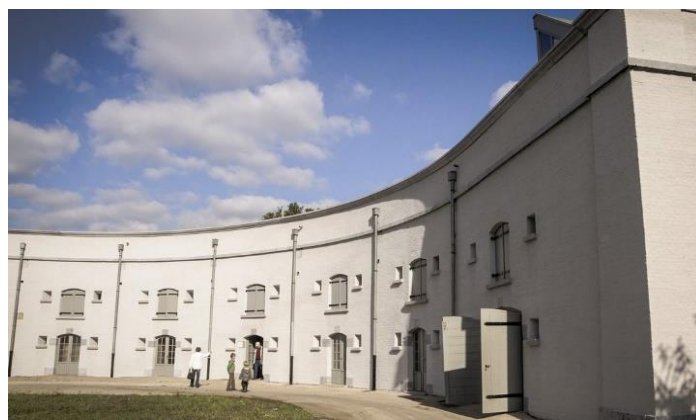
Een deel van het fort is in een halve cirkel gebouwd.
